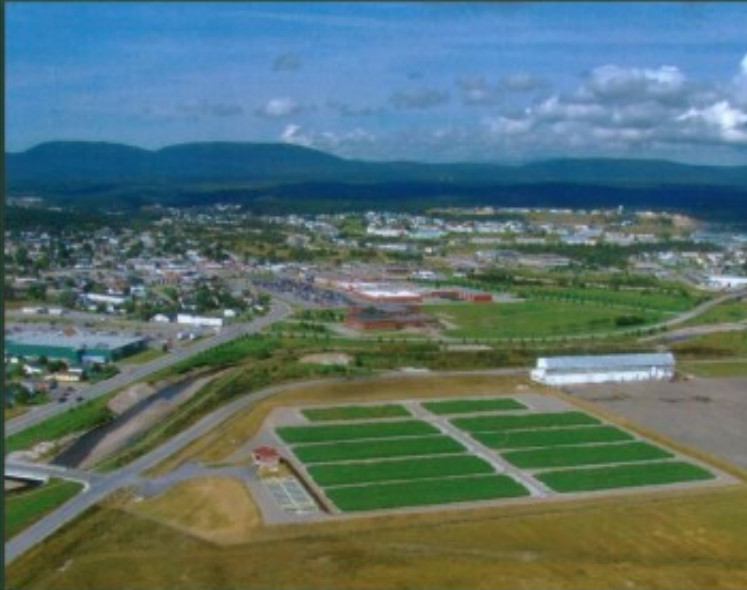
Stephenville Municipal Wetland
